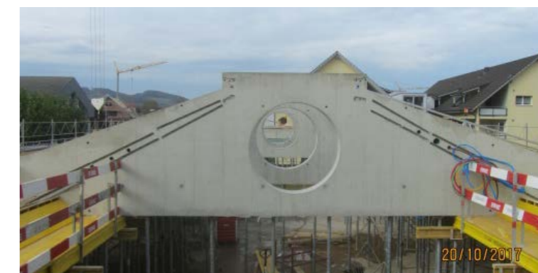
Ansicht vorgespannter Ortbetonträger
